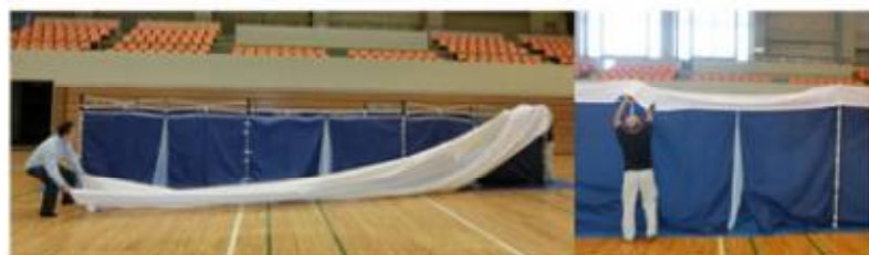
2棟設置後、補強パイプを連結します
