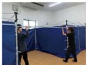
2棟設置後、補強パイプを連結します
