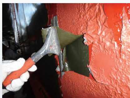
手工具による塗膜はく離作業状況
