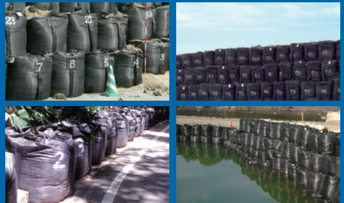
●被災護岸の緊急仮復旧 ●土砂災害時の救急仮復旧 ●災害発生時の河川・道路・海岸・地滑りなどの復旧工事
