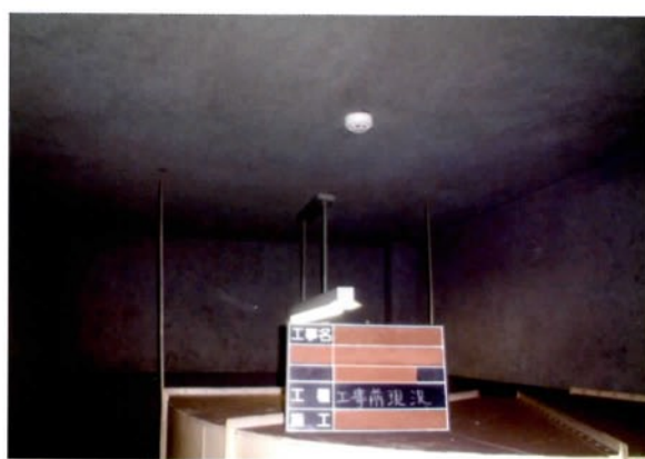
内部浸透処理前
