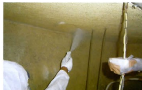
アステクターS吹付け
