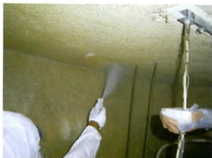
アステクターS吹付け
