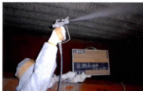
アステクターR吹付け
