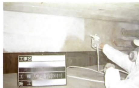
アステクターCW吹付け
