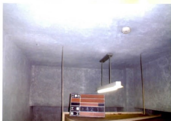
内部浸透処理後
